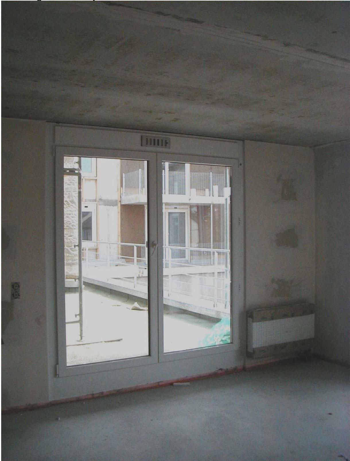
**Bild 13.** Zuluftelement ZLE 50 im aufgedoppelten Rahmen über der Tür eingebaut.
