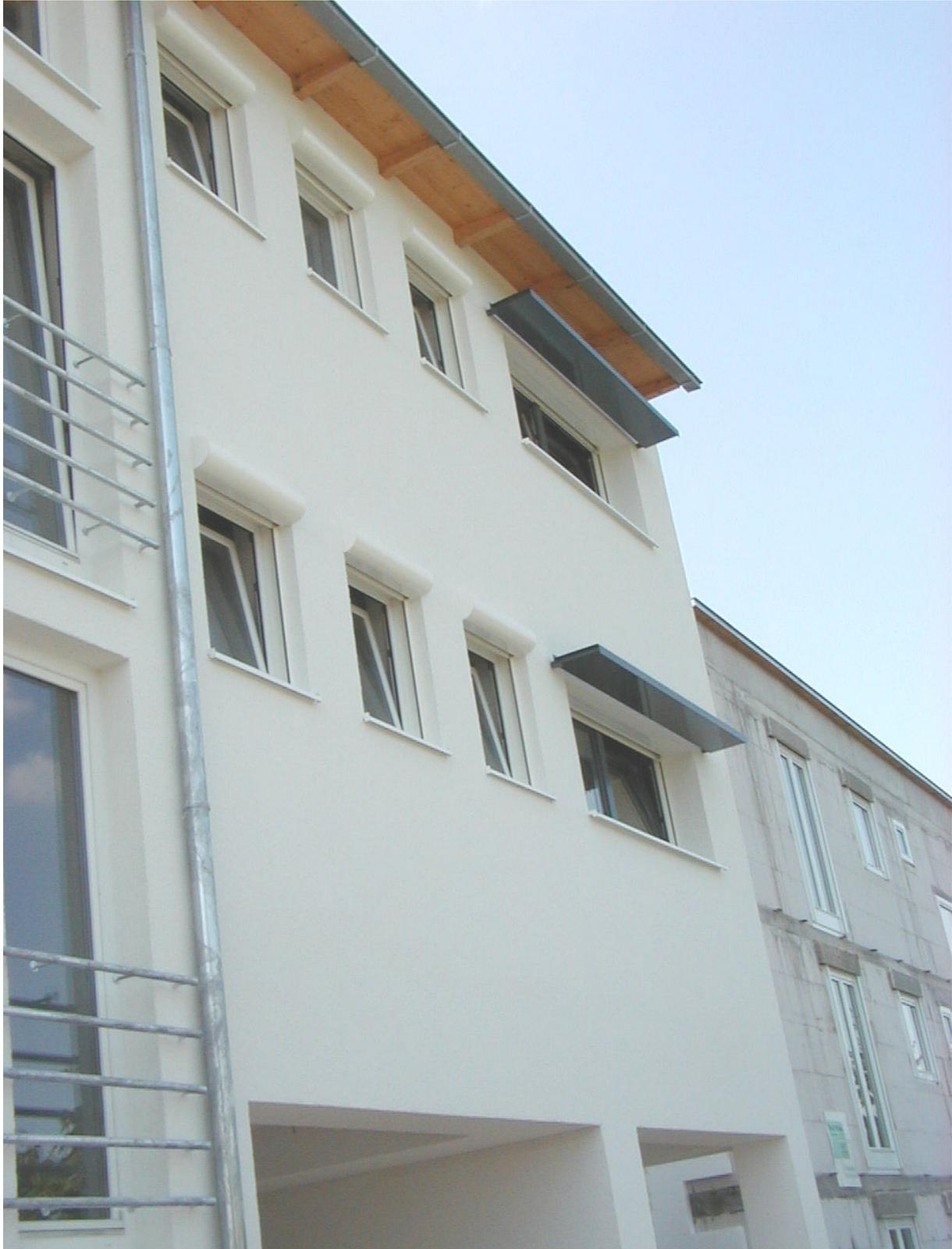
**Bild 17.** Fassadenansicht eines Wohngebäudes mit eingebautem Zuluftelement ZLE 50. Die Zuluftöffnungen befinden sich hinter den Rolladenkästen.
