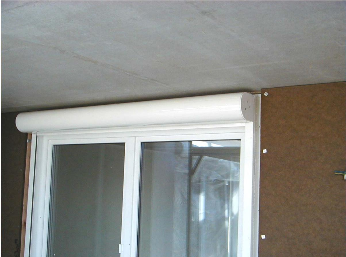
**Bild 16.** Außenseite des Fensters mit vorgebauten Rolladenkasten. Die Zuluftöffnung des Zuluftelements ZLE 50 befindet sich hinter dem Rolladenkasten.
