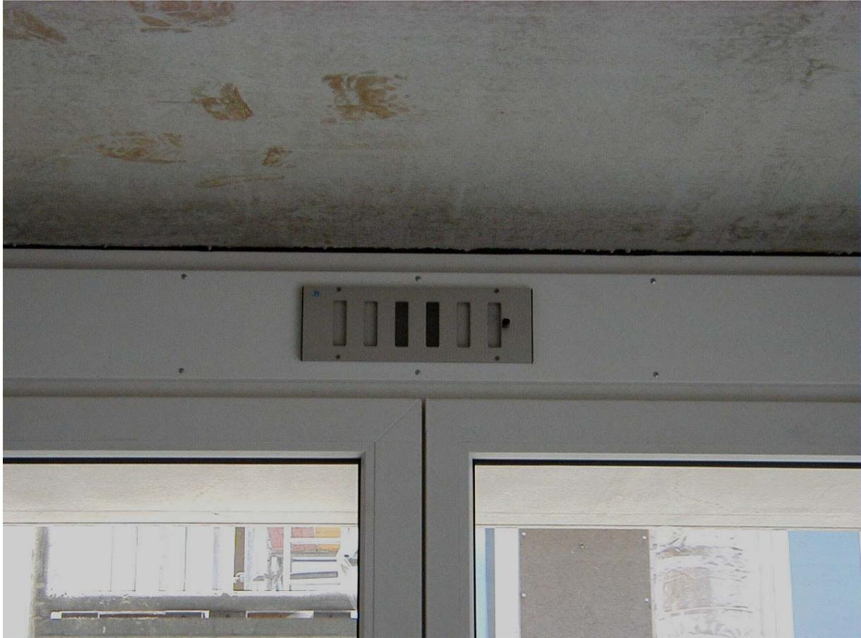
**Bild 14.** Detailansicht. Stufenlos verstellbares Schlitzgitter am Lufteintritt auf der Raumseite.
