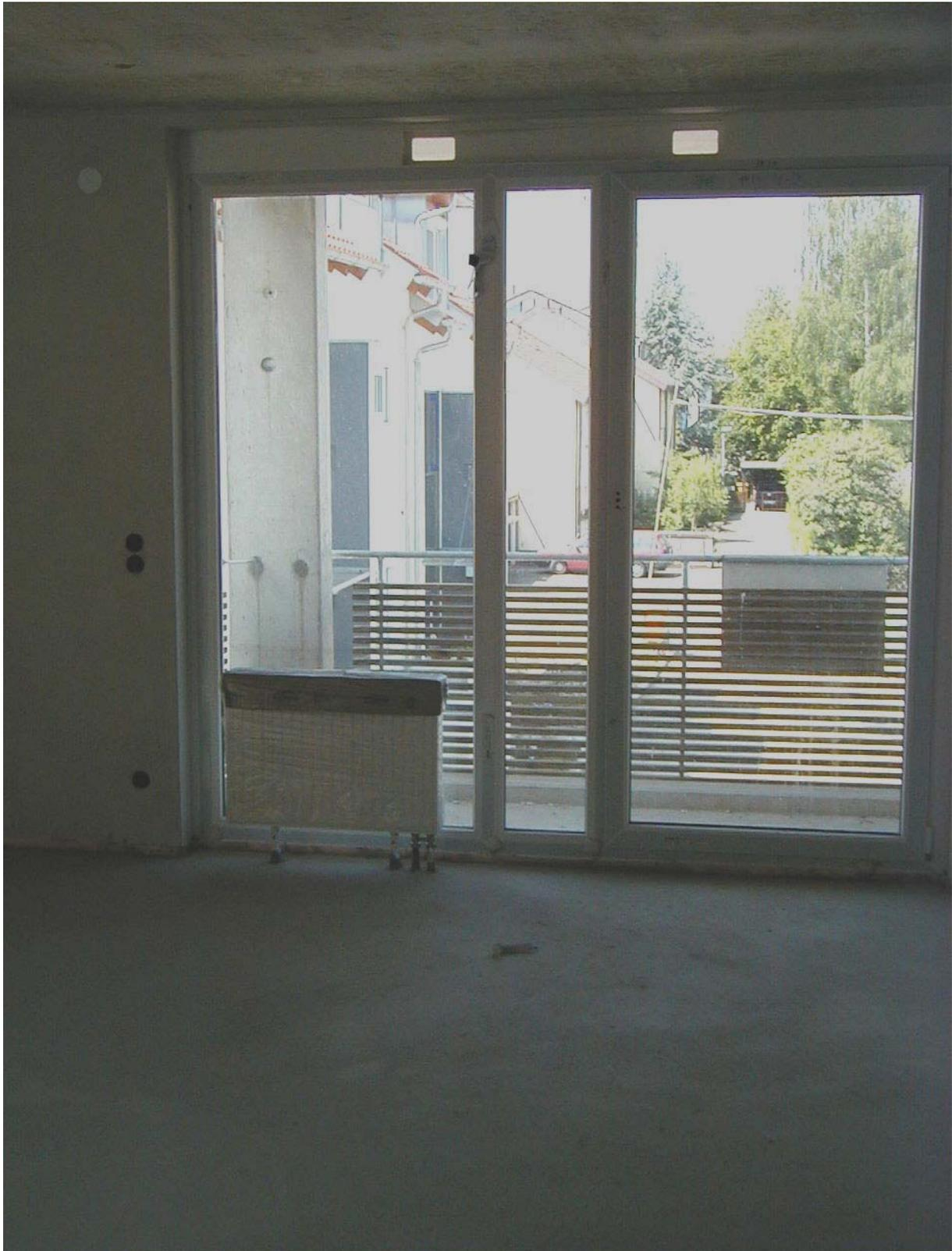
**Bild 15.** Aussparung im aufgedoppelten Rahmen für den Einbau des Zuluftelements ZLE 50.
